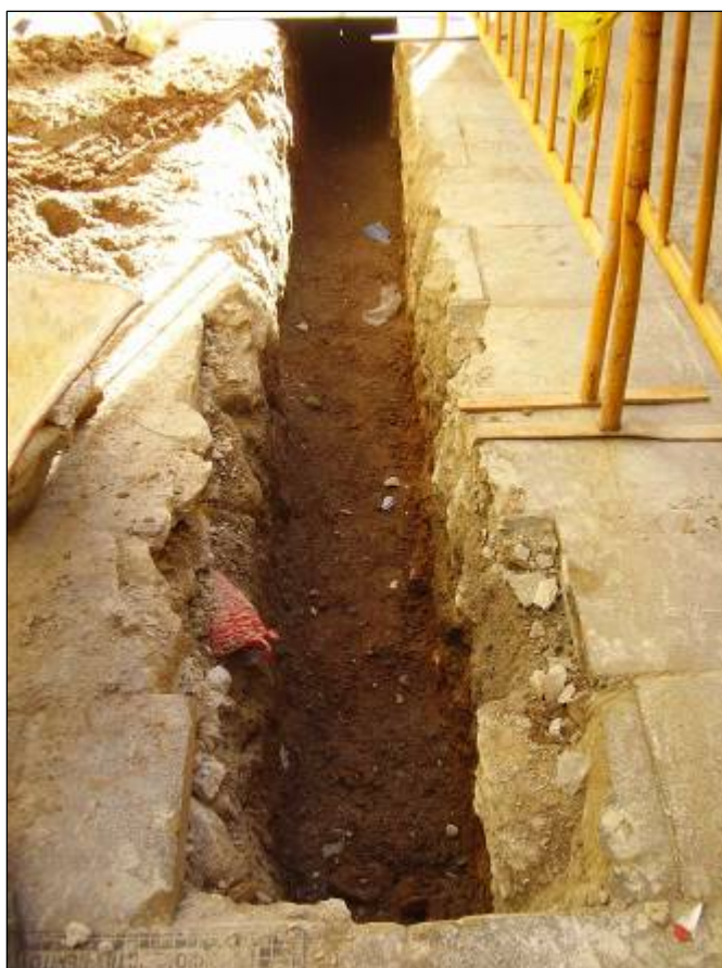
Foto 7: Final de l'excavació de la rasa al carrer Templers.
