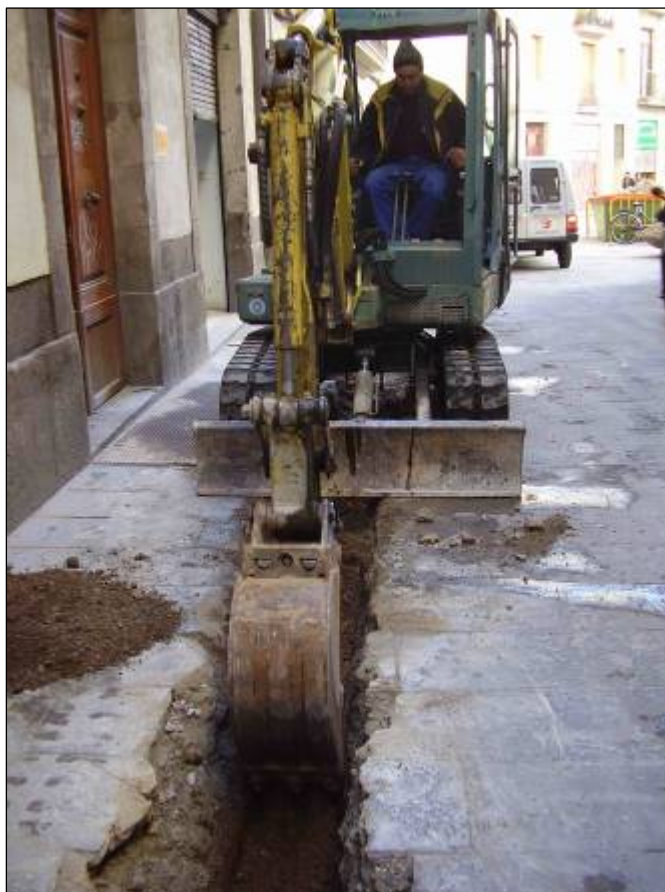
Foto 6: Inici de l'excavació de la rasa del carrer Templers a la meitat pròxima a l'encremanet amb el carrer Ciutat.
