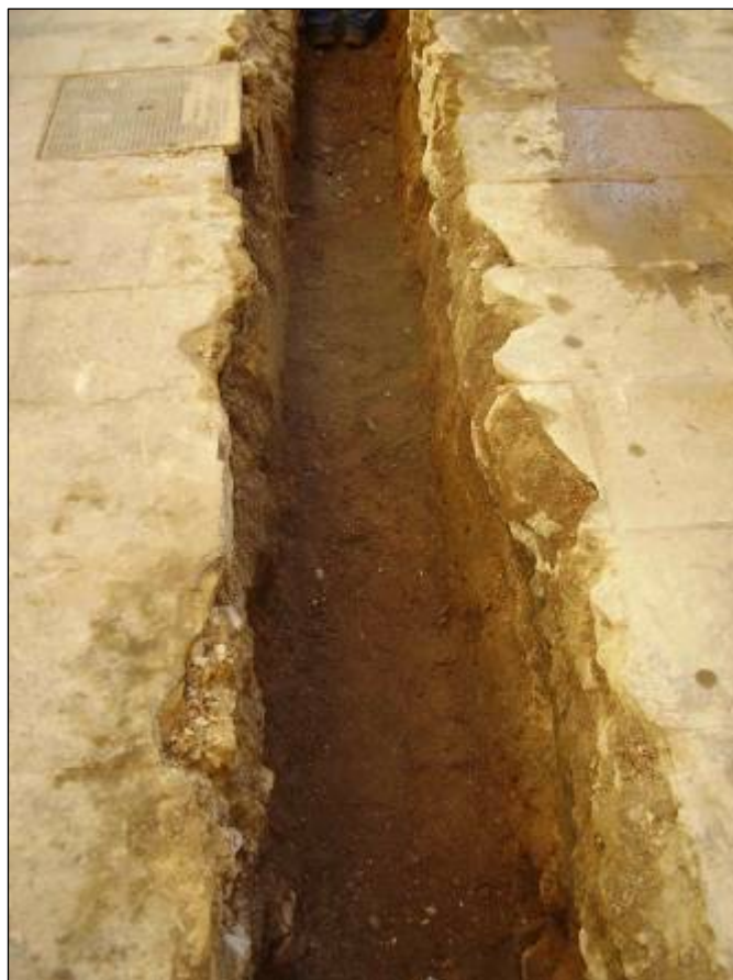
Foto 8: Final de l'excavació de la rasa al carrer Templers.
