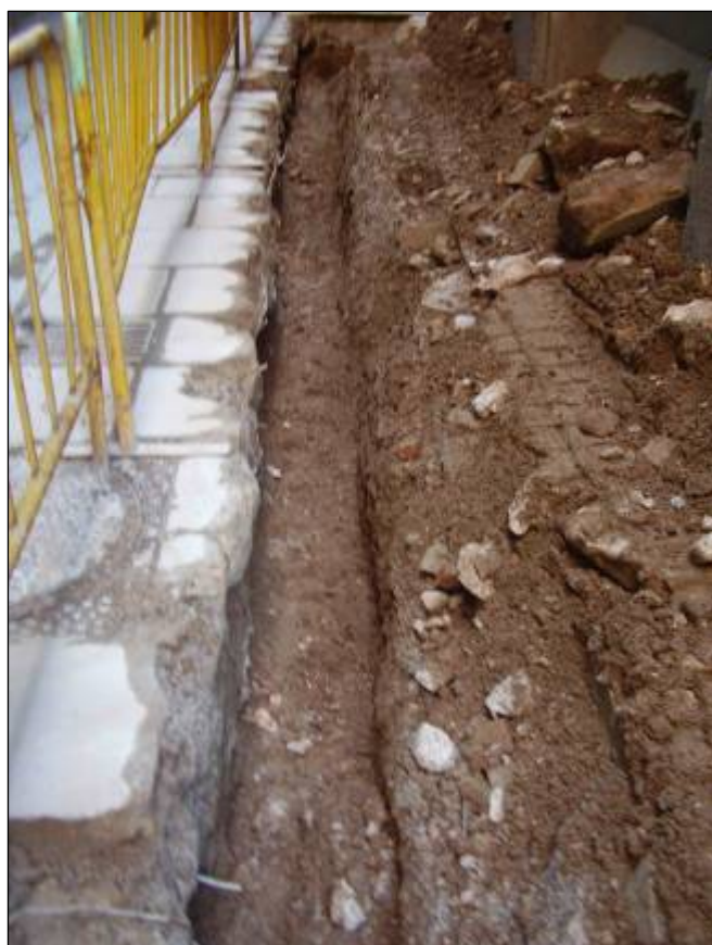
Foto 11: Finalització de la rasa al carrer Bellafila.
