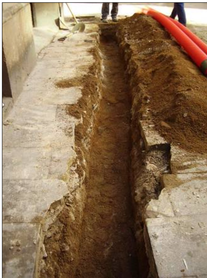
Foto 4: Rasa del carrer Templers, part superior de la capa de formigó que apareix sota l'estrat de sorres (UE 104).
