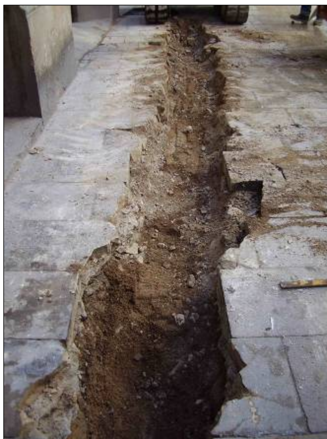
Foto 3: Rasa del carrer Templers, abans de començar l'excavació de l'estrat de sorres (UE 103).
