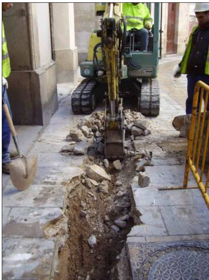
Foto 2: Inici de l'excavació de la rasa situada al carrer Templers.
