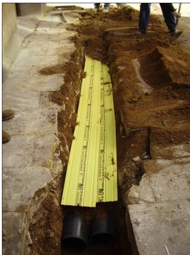
Foto 5: Rasa del carrer Templers, després de la col·locació dels tubs i del cobriment de la rasa.
