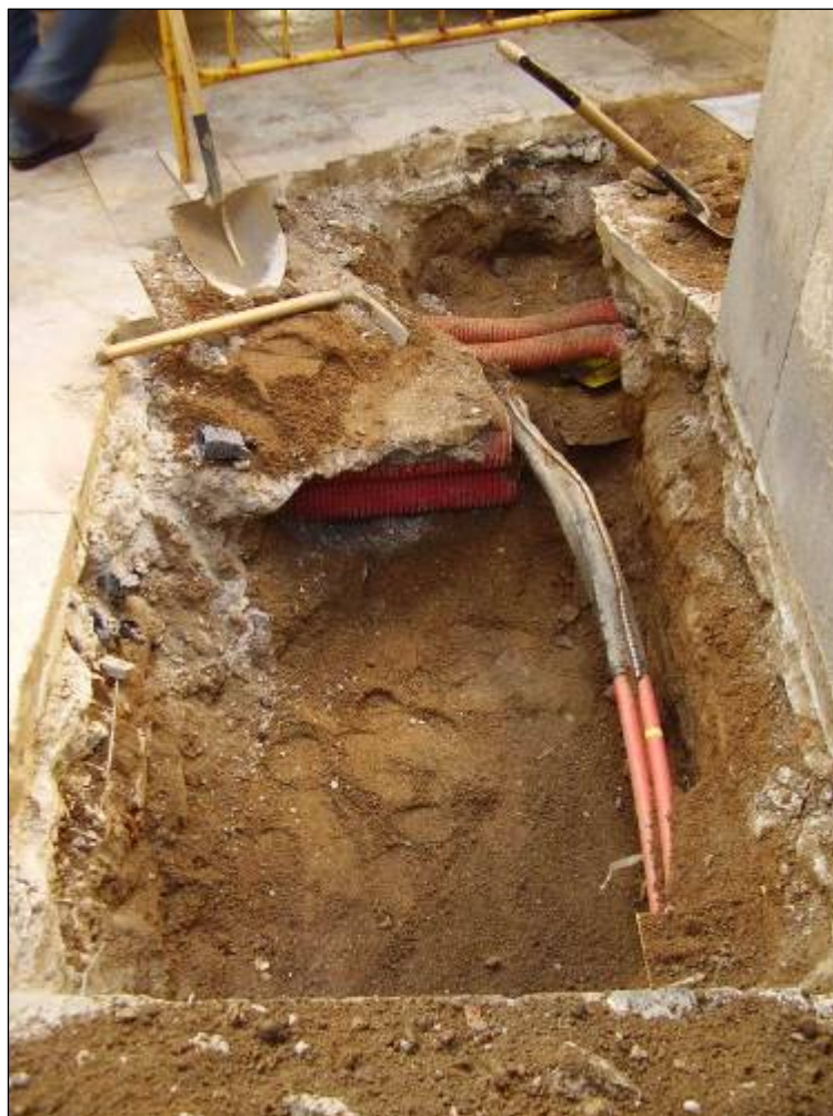
Foto 1: Sondeig realitzat al carrer Ataulf, a la cantonada amb el carrer Templers.
